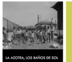
LA AZOTEA, LOS BAÑOS DE SOL
